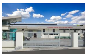
MPP Plant Teluk Emas, Melaka
